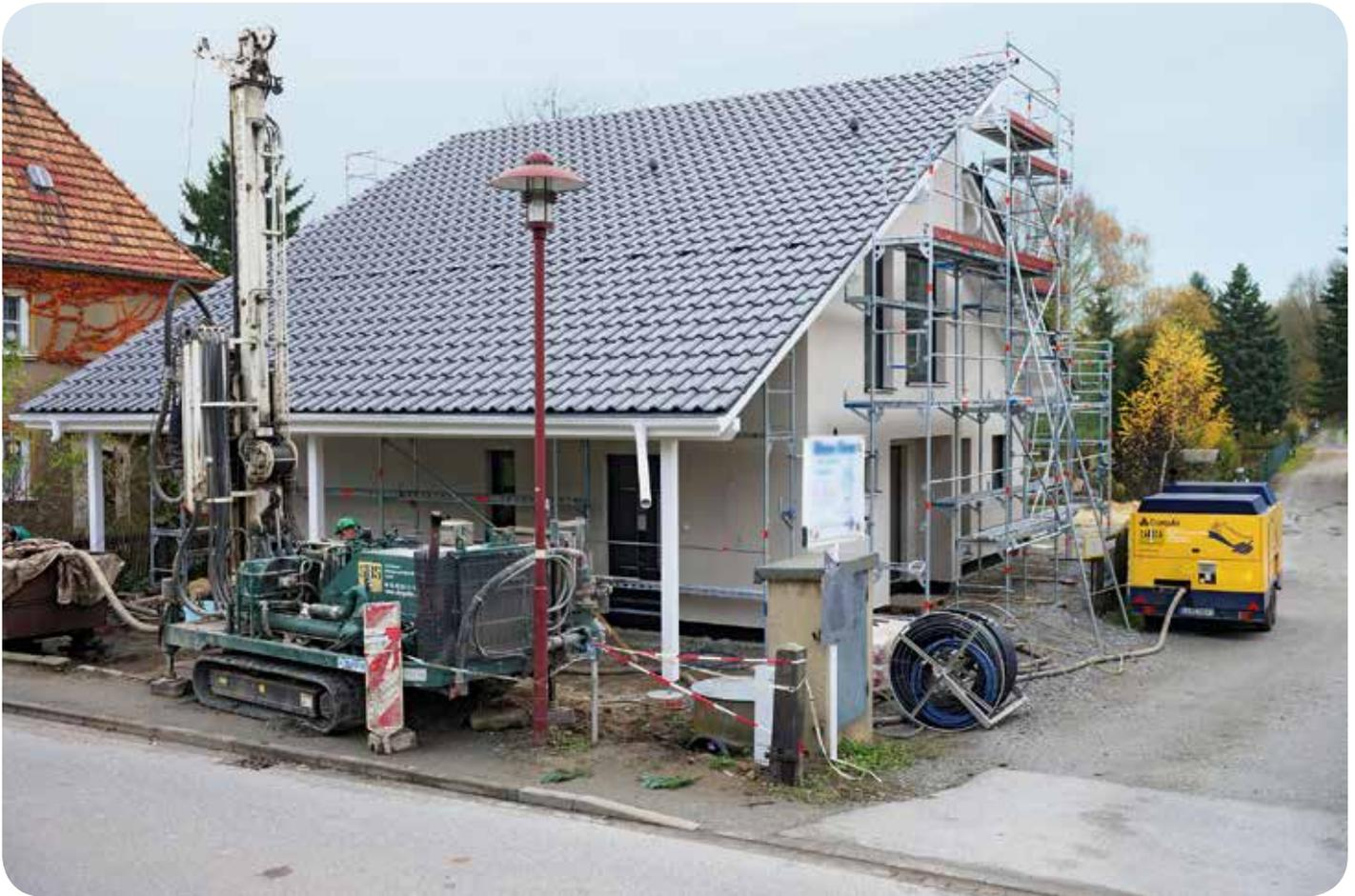
**SBS braucht eine Kompressorleistung von 21 bar, um Erdwärmesonden bis auf 100 Meter Tiefe einzubringen.**
