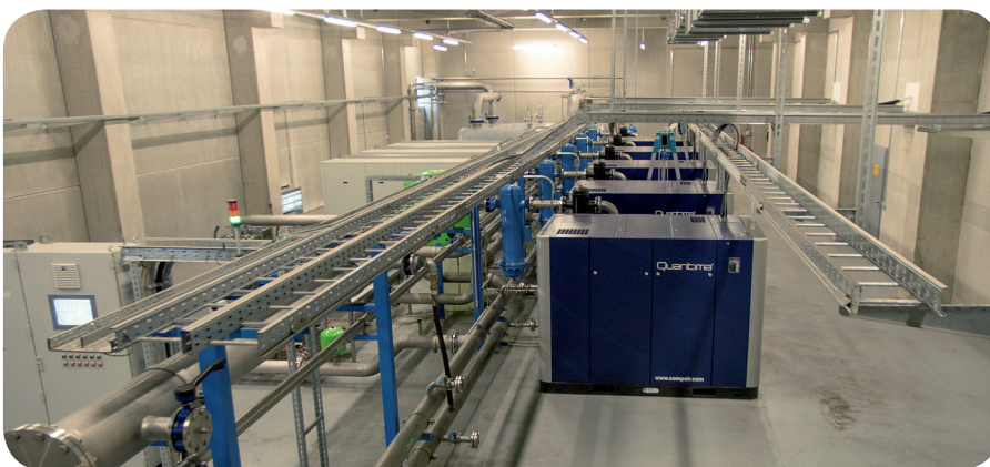
Speicher, Wasserkühlung mit Pumpen und Wärmetauschern sowie die komplette Verrohrung wurde von CompAir übernommen.
