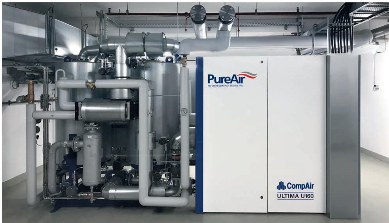
**Per asciugare l'aria compressa umida, si utilizza un essiccatore HOC (Heat Of Compression) (a sinistra). Questo utilizza quasi tutto il calore di scarto del compressore per rigenerare l'essiccante.**
