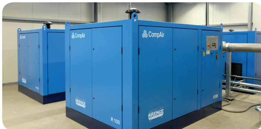
Vier baugleiche Kolbenkompressoren erzeugen die Druckluft für Wergona – effizient, ölfrei und in acht Volumenstrombereichen.
