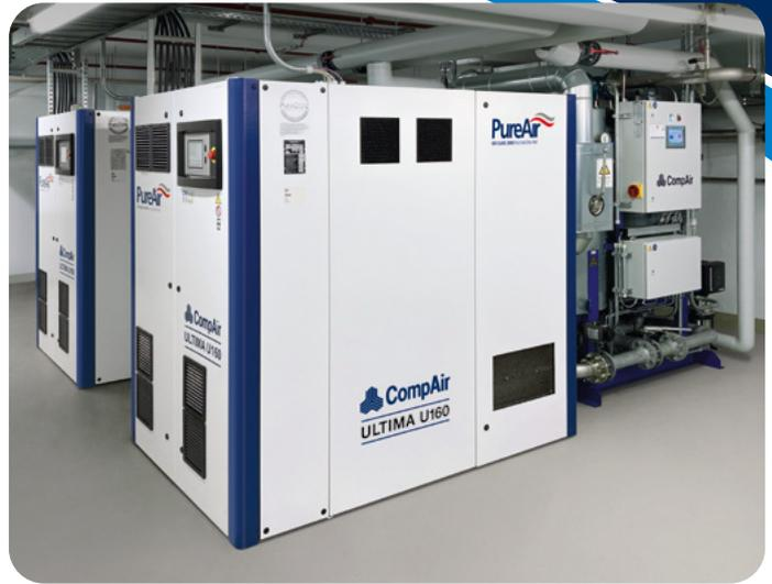
A pesar del espacio limitado en la sala de la planta, fue posible instalar dos compresores Ultima combinados con dos secadores de adsorción HOC debido a su pequeño tamaño.
