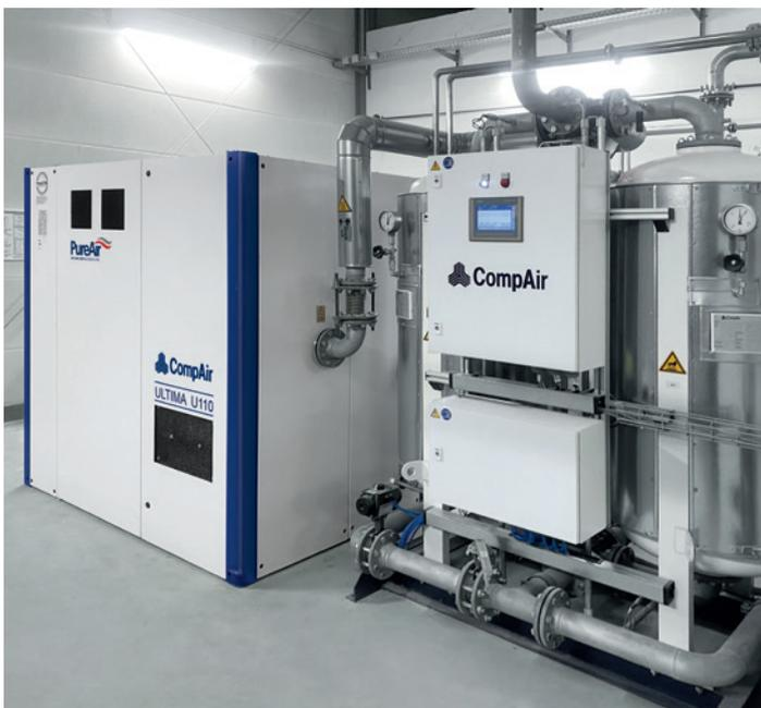
Como parte del posterior proceso de cualificación del rendimiento, el equipo recopiló datos a lo largo de un mes para asegurarse de que el aire comprimido se mantenía impecablemente limpio. Mientras tanto, el sistema de aire comprimido está en funcionamiento, y los niveles de punto de rocío o de ausencia de aceite se registran continuamente en línea, al tiempo que se realizan mediciones discretas de partículas o recuentos bacterianos a intervalos regulares.
